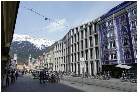
図3 歴史的街並みに並んで建設されている現代建築
