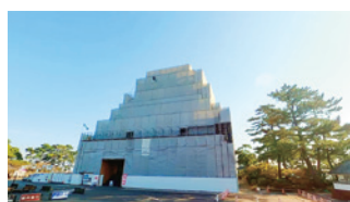
タイムラプス映像による施工の様子
