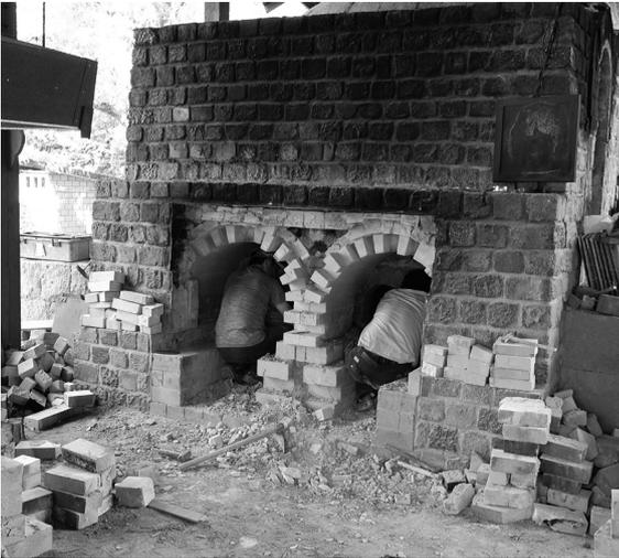
5) トンバイ<sup>10)</sup> および耐火煉瓦で灰の取出口を構築する
