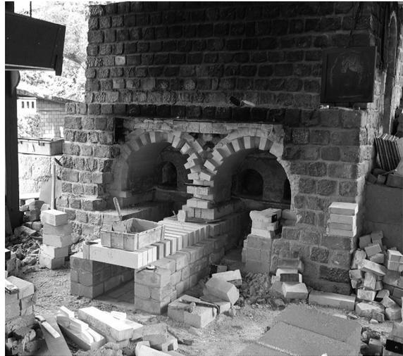
3) 窯前方に耐火煉瓦を敷設するための窪みを掘削する
