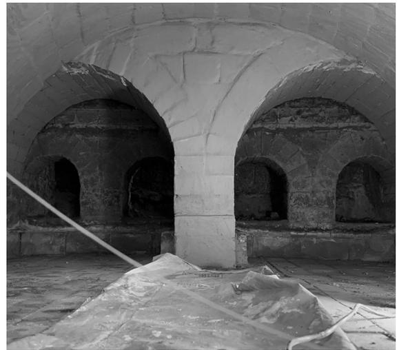
9) 成形したトンバイを用いて天井部分を形成する
